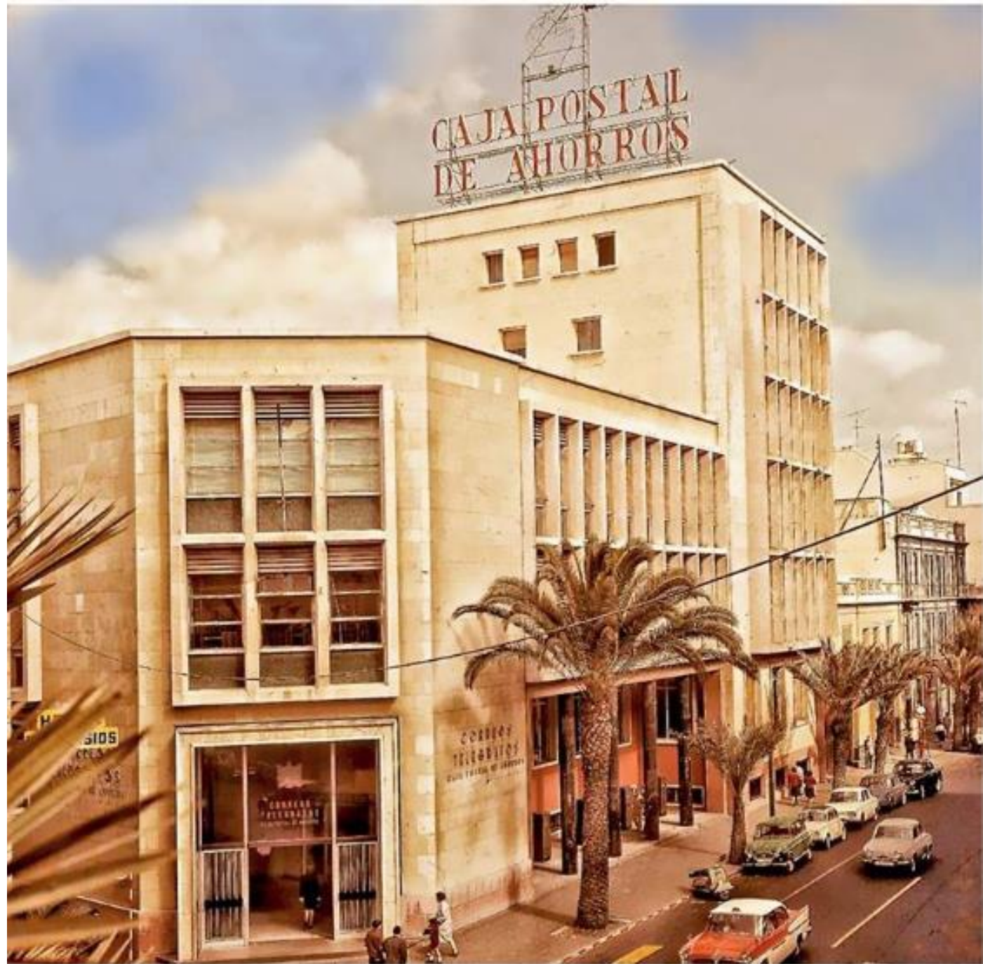
Edificio de correos – 1965
